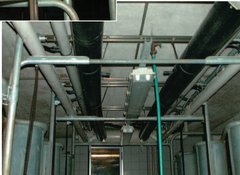
Anpassungen an Luft- und Melkleitungen.
