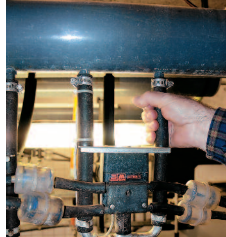
Die Pulsatoren wurden ebenfalls frei hängend montiert.
